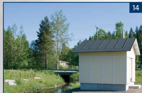
Канализационные станции с «мокрым» колодцем могут поставляться как с павильоном для обслуживания 2,5 x 2,5 м или 3,3 x 3,3 м, смонтированным на поверхности земли, так и без него. Помещение изолировано над колодцем и может быть оснащено системой отопления и/или кондиционирования воздуха.
