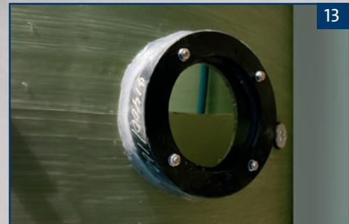
Фланец (стальной) или уплотнительная манжета на входе для самотечной трубы из PE/PVC диаметром до DN 1000.
